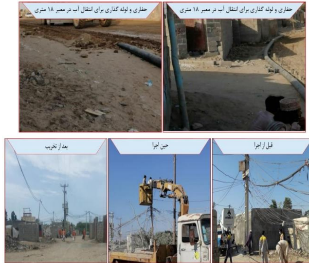
شکل ۷. تصاویری از اجرای خدمات زیربنایی (آب و برق)
