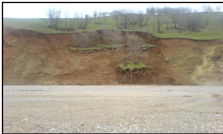
شکل ۹: لغزش توده سست (سارند گورپی) در اثر تخریب سطح اتکای دامنه در اثر اعمال مکانیکی احداث جاده
